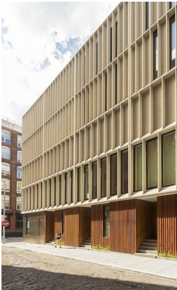
Imagine de referinta pentru modalitate de executie fatada ventilata ancadrame metalice
