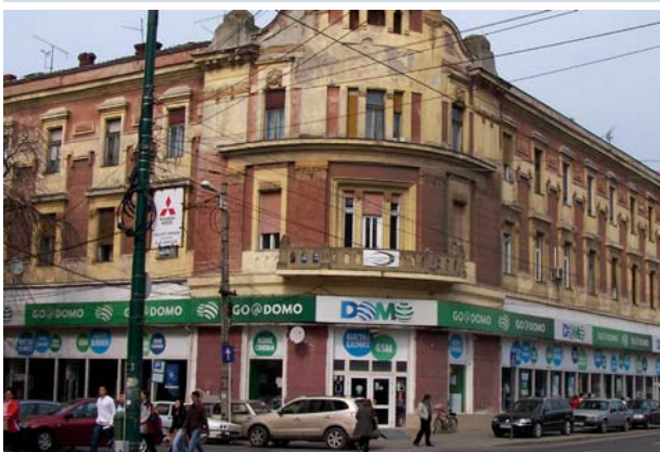
GREȘIT! Exemple de tratare necorespunzătoare a fațadelor istorice. Spațiile comerciale de la parter și vitrinele aferente nu respectă nici principiile constructive și nici aspectul estetic al clădirilor istorice.
