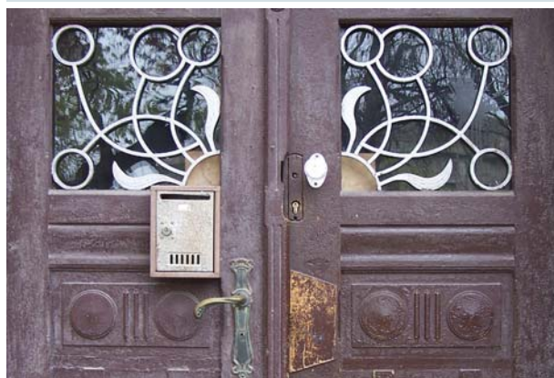
GREȘIT! Din păcate, la poarta originală, unele piese istorice au fost înlocuite cu elemente noi, nepotrivite pentru clădirea istorică.
