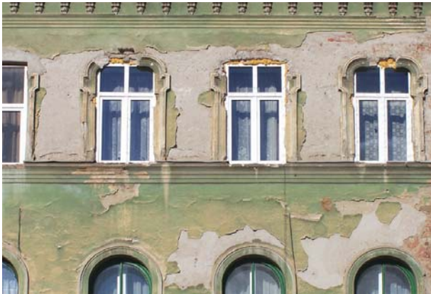
GREȘIT! Ferestrele istorice valoroase, din lemn, au fost înlocuite cu ferestre ieftine din PVC, un material plastic.
