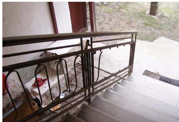
GREȘIT! Balustrada din metal este deteriorată parțial. Există pericolul producerii de accidente.
