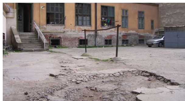
GREȘIT! Curte interioară cu pavaj deteriorat.
