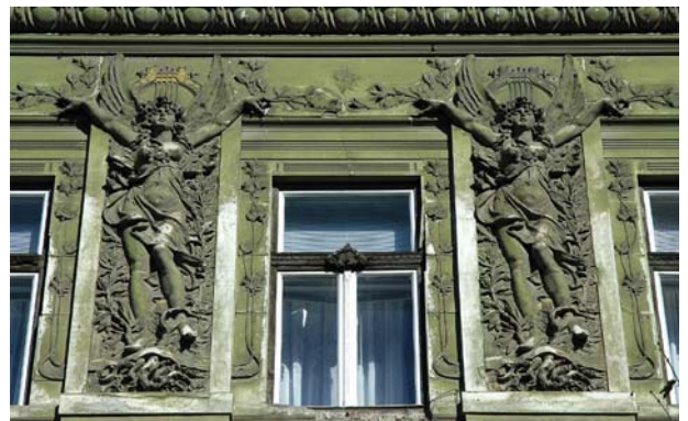
MARE PĂCAT! Fațadele degradate și ornamentele distruse iremediabil afectează foarte negativ aspectul clădirilor istorice. Ele duc și la deteriorări grave ale zidăriei, care nu mai este protejată împotriva intemperiilor.
