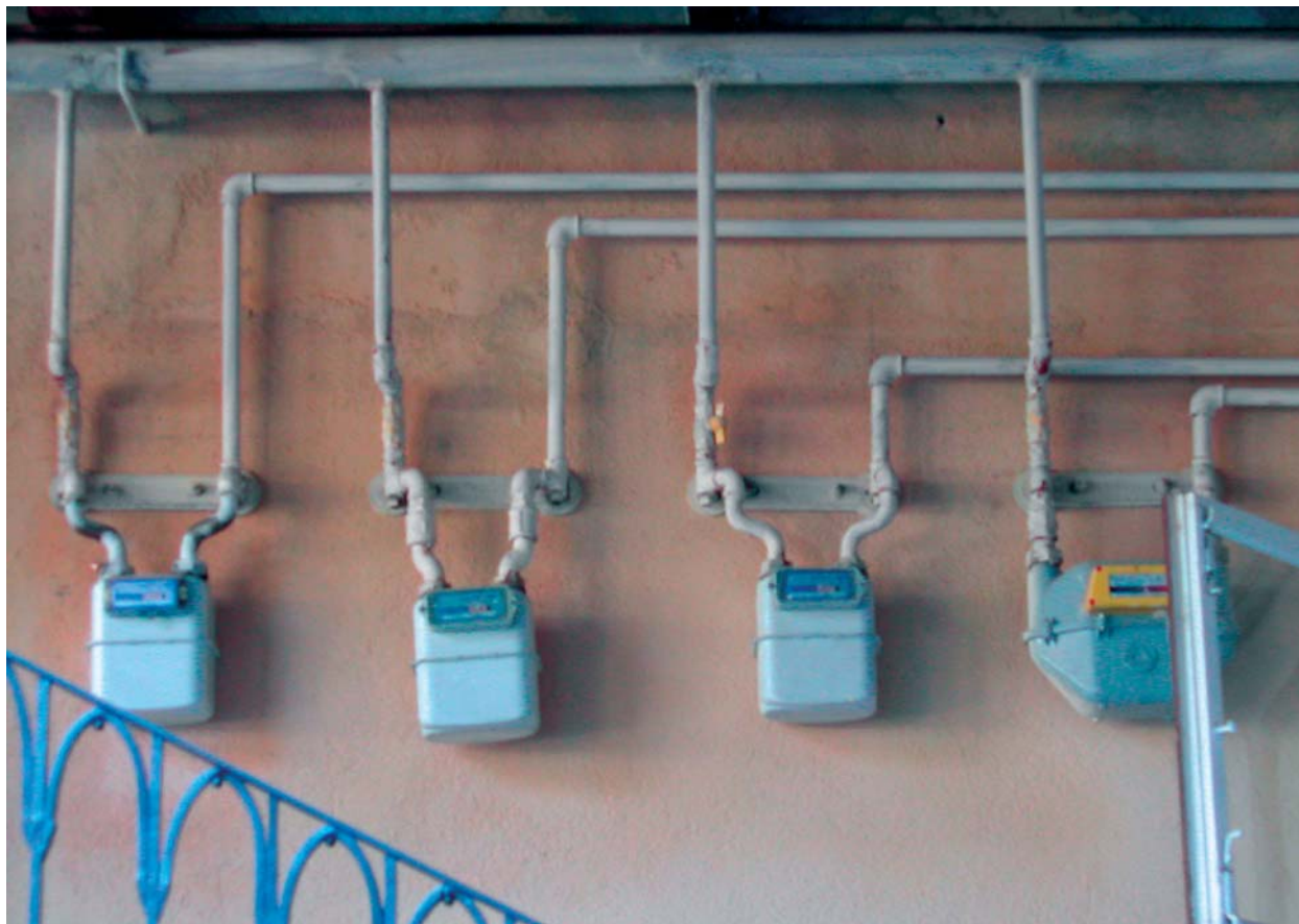
CORECT! Instalațiile tehnice, contoarele și conductele trebuie grupate într-un singur loc, cât mai discret.
