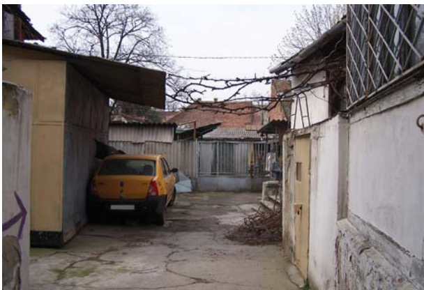
GREȘIT! Curte interioară năpădită de construcții parazitare.
