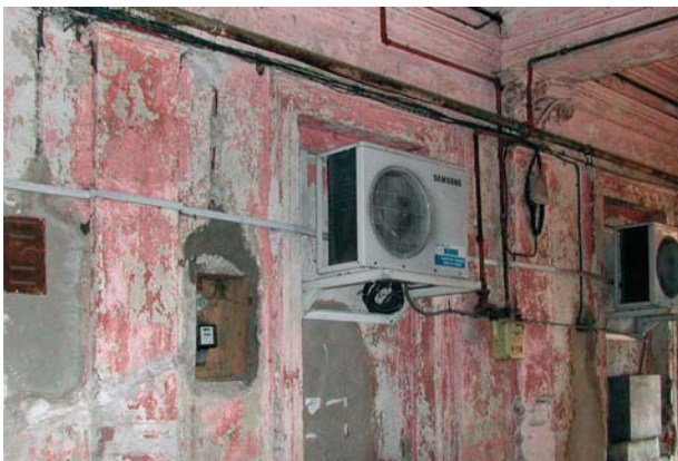
GREȘIT! Instalațiile tehnice sunt amplasate arbitrar și influențează negativ aspectul curții interioare.
