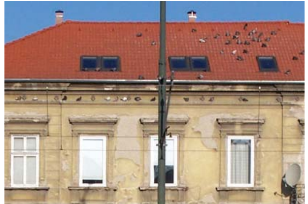
REGRETABIL! Ferestrele de tip Velux din planul învelitorii, vizibile din spațiul public al străzii, contravin aspectului istoric al clădirii.
