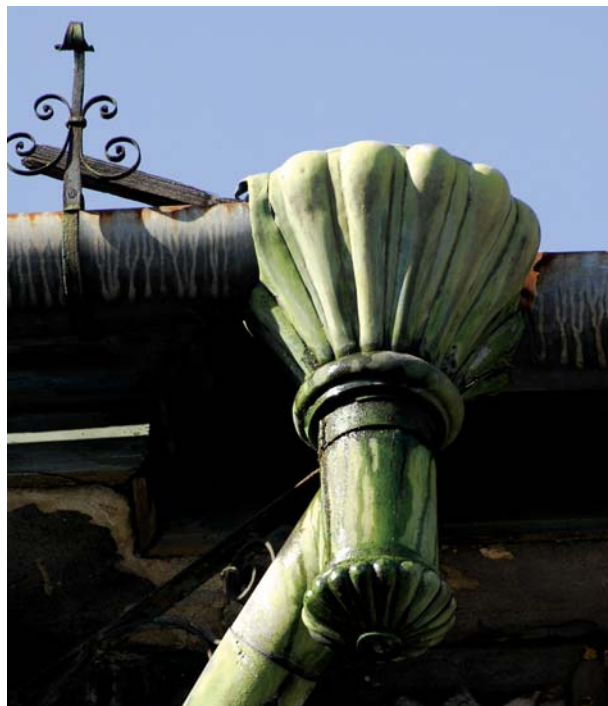
VALOARE ESTETICĂ! Vazon istoric de legătură, între jgheab și burlan, și cârlige de jgheab istorice. Ele trebuie neapărat conservate și restaurate.
