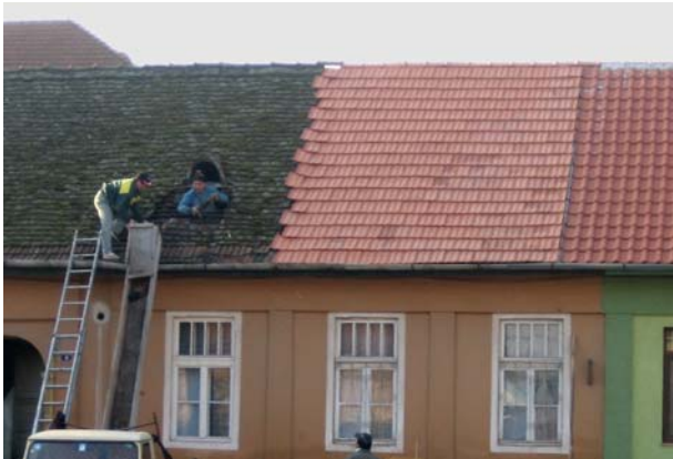
GREȘIT! În locul țiglelor "solzi" originale, pe suprafața cu învelitoare nouă, s-au folosit țigle profilate, atipice pentru zonele istorice.
