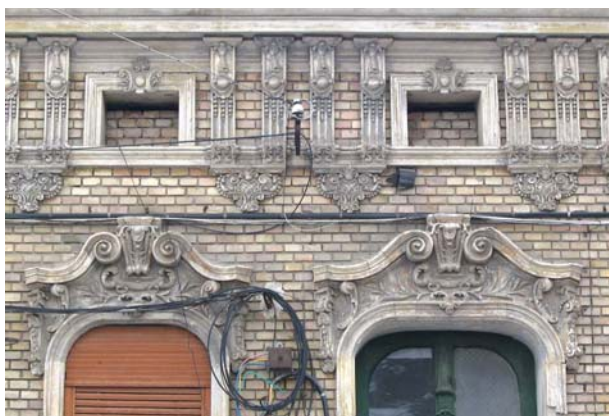
GREȘIT! Cablurile și conductele, montate absolut haotic pe fațadele istorice, produc un efect extrem de neplăcut.
