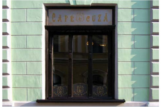
CORECT! Ferestrele istorice au fost reconstruite cu geamuri termopan și tâmplărie din lemn.
