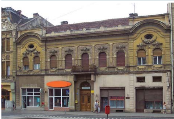
GREȘIT! Exemple de tratare necorespunzătoare a fațadelor istorice. Spațiile comerciale de la parter și vitrinele aferente nu respectă nici principiile constructive și nici aspectul estetic al clădirilor istorice.
