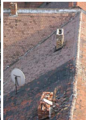
Coșuri de fum deteriorate, încălzirea nu poate funcționa corect.
