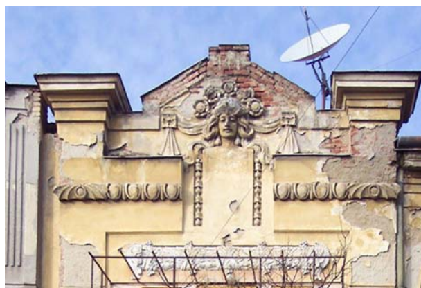
GREȘIT! Antenele parabolice trebuie montate astfel, încât să nu fie vizibile dinspre stradă.
