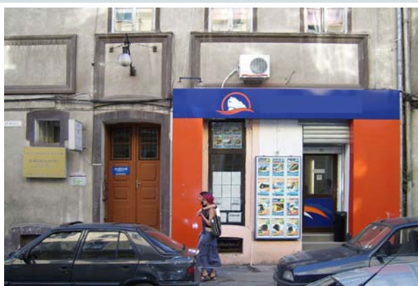
GREȘIT! Firma magazinului acoperă elemente constitutive ale fațadei. Ea nu se potrivește nici ca material și nici cromatic cu fațada istorică.
