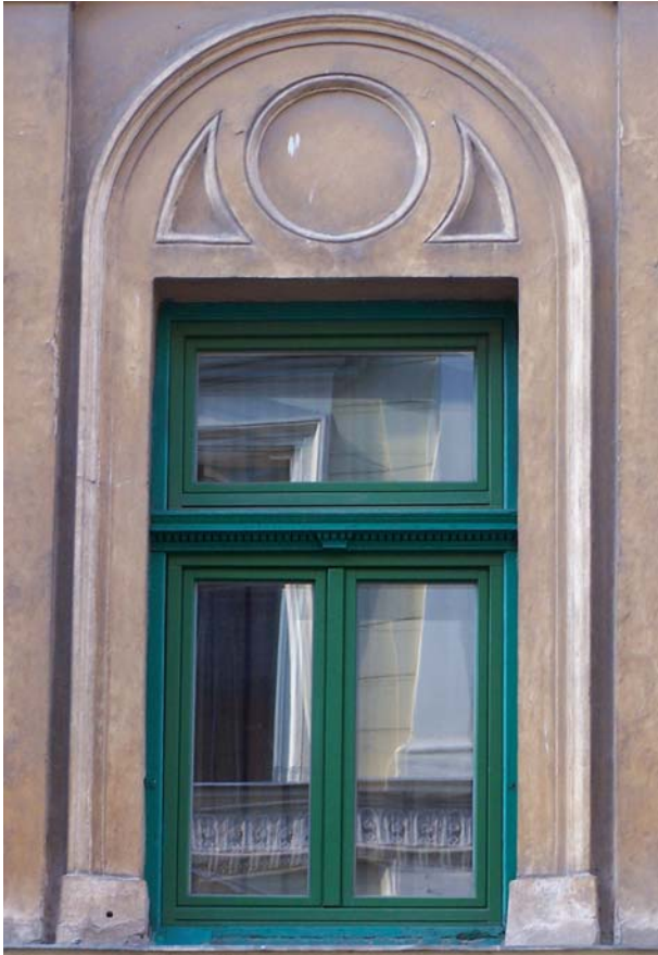
CORECT! Tâmplăria ferestrelor este realizată din lemn, cu geamuri termopan, respectându-se modelul istoric.
