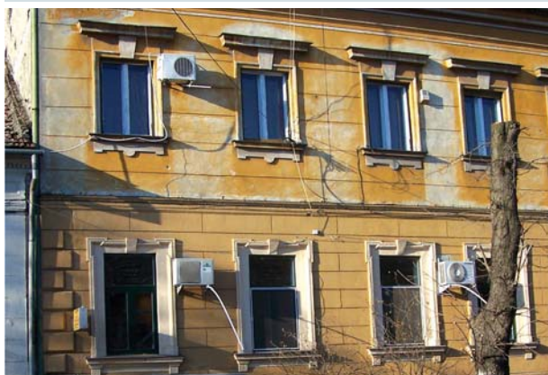
GREȘIT! Instalațiile de climatizare, montate pe fațadele dinspre stradă, alterează aspectul ansamblurilor istorice.
