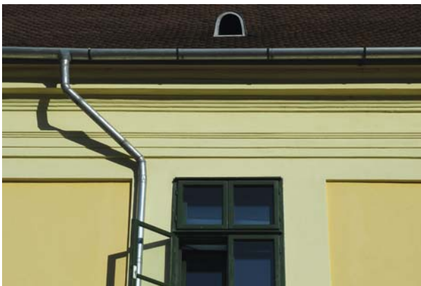
CORECT! Jgheaburile / burlanele noi de evacuare a apei, respectiv cele care sunt corect întreținute, protejează fațadele împotriva apei meteorice.
