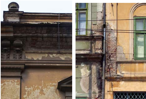
GREȘIT! Jgheaburi și burlane de evacuare a apei meteorice defecte duc la degradări masive ale fațadelor.
