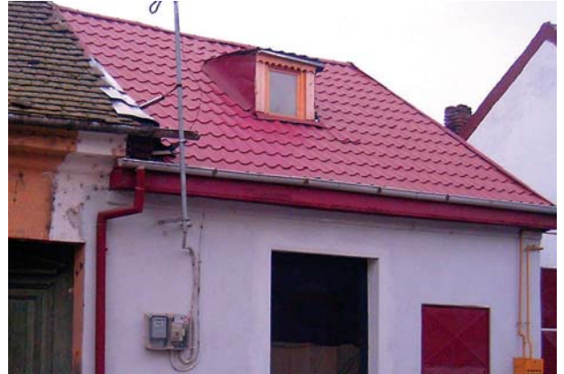
GREȘIT! Înveltoarea acoperișului original a fost înlocuită cu o alta din material plastic. Nici lucarna nu corespunde formelor tradiționale, istorice.
