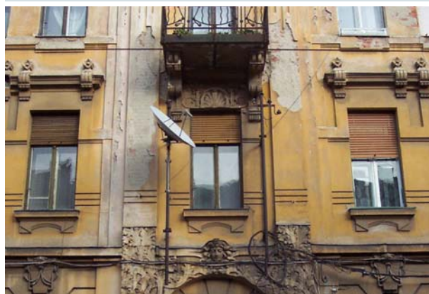
GREȘIT! Se interzice montarea antenelor și a cablurilor vizibil pe fațadele istorice, pentru că alterează grav aspectul clădirilor.
