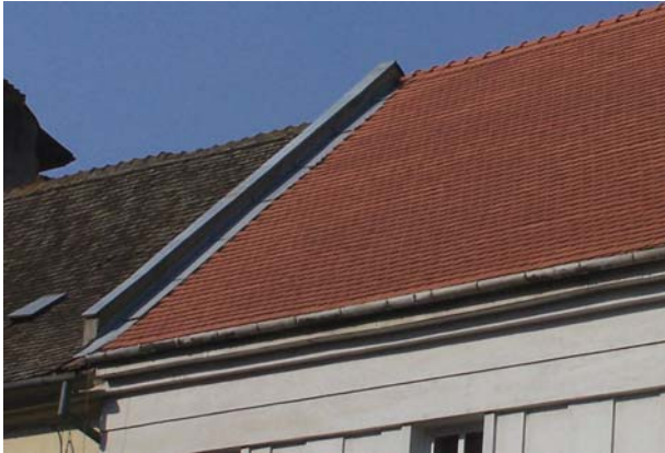
CORECT! La repararea acoperișului au fost utilizate țigle tipice pentru zonele istorice ale Timișoarei.
