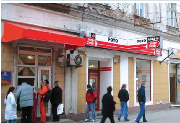
GREȘIT! Atât copertina, cât și firma, nu se potrivesc nici ca formă și nici cromatic cu fațada istorică.
