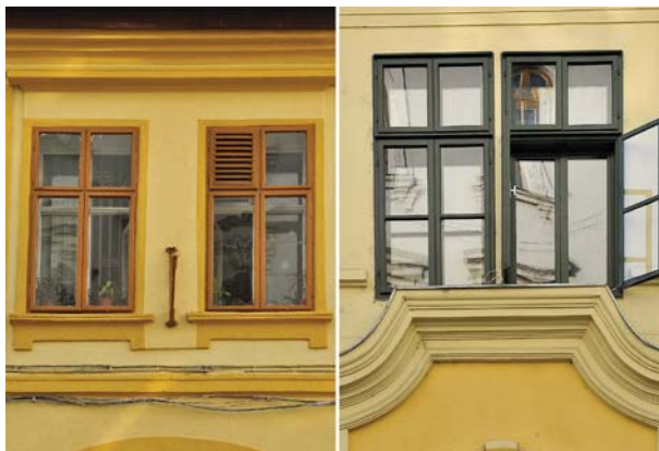
Ferestre istorice simple, de tip "casetă". Canatul exterior al ferestrei se deschide către exterior.
