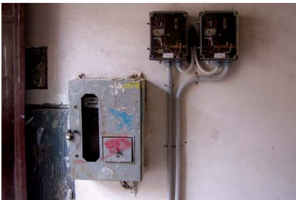
CORECT! Instalațiile tehnice sunt grupate corect, în gangul de intrare, și nu alterează aspectul plastic al fațadei.
