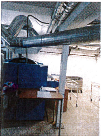
Calandru pe abur dezafectat, Vas A.C. condens scos din uz, Pompa combustibil
