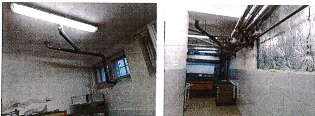
Instalații canalizare realizate ulterior pentru a servi zona de sterilizare
