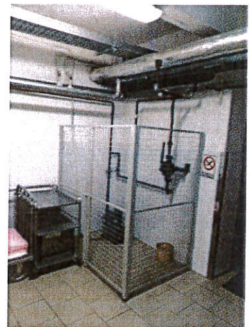
Calandru pe abur dezafectat, Vas A.C. condens scos din uz, Pompa combustibil
