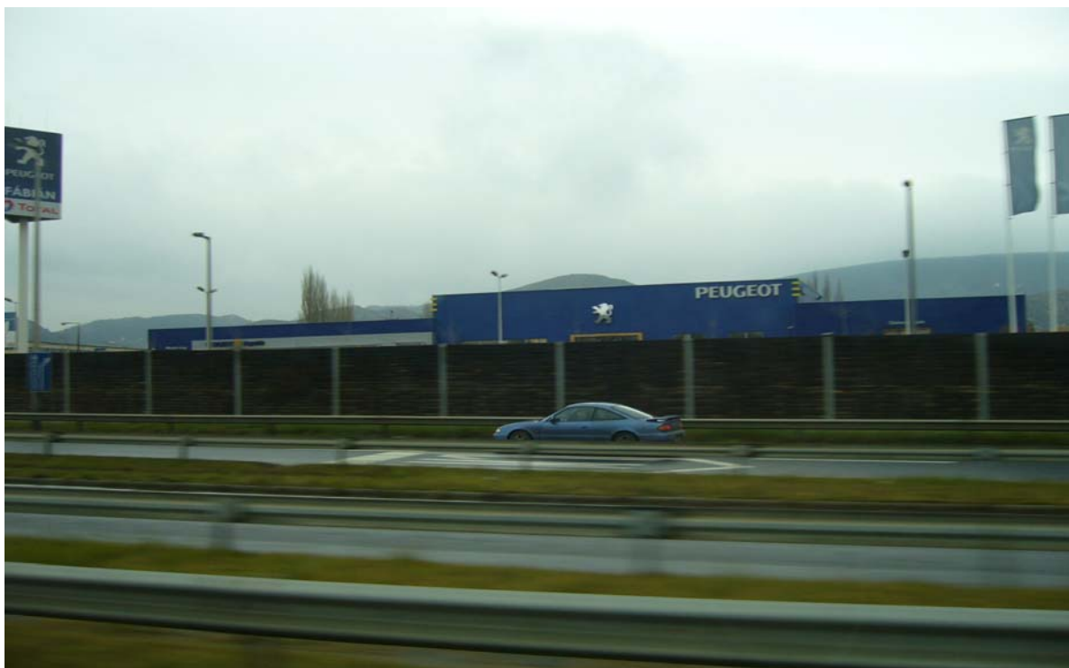
Panouri fonoabsorbante situate de-a lungul căilor de rulare
