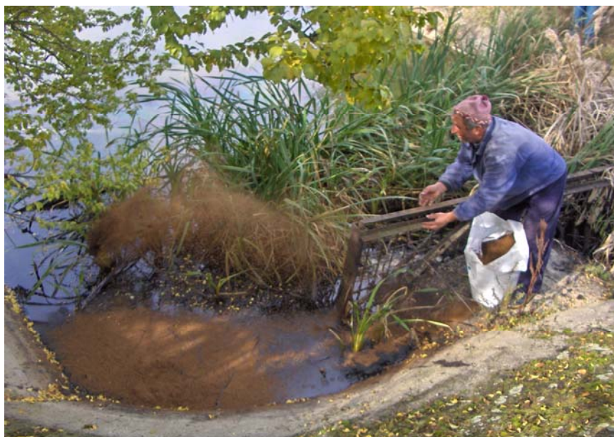
Balta Subuleasa - aplicarea materialului absorbant
