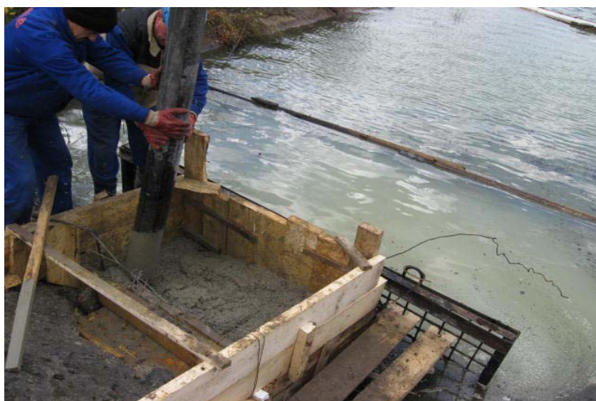
Balta Subuleasa – blindarea conductei de deversare
