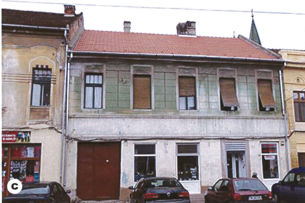
a) Str. Ștefan cel Mare nr.23 (fațadă reabilitată, dar fără acoperiș), b) Splaiul Nistrului nr.1 (stare generală peste medie), c) Str. Ștefan cel Mare nr.14 (acoperiș reabilitat, dar fără fațadă) – imagini mai 2015
