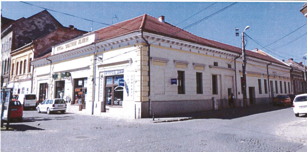
Str. Zăvoi nr. 1 (foto sus 2007 – foto jos 2015)
