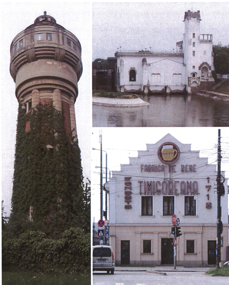
Turnul de apă din Fabric, Turbinele și Fabrica de bere
