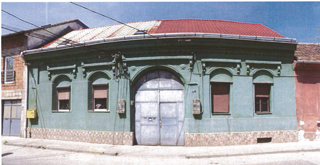
Exemplu de placare cu gresie a soclului: Str. Timocului nr.9
