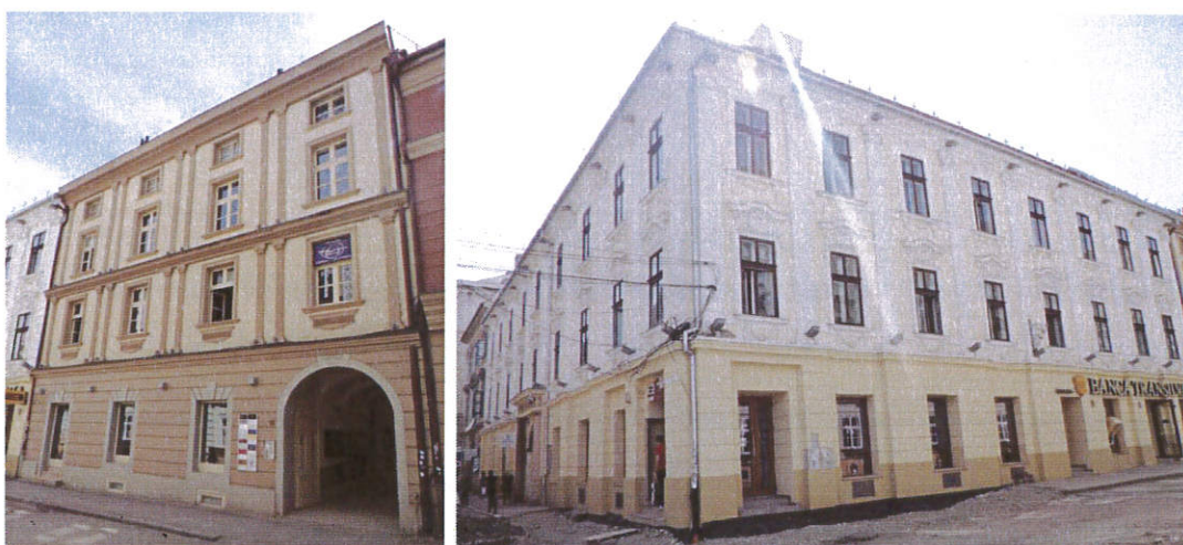
Imobile istorice reabilitate: Str. Augustin Pacha nr. 10 și Str. Palanca nr. 2. Spațiile disponibile sunt valorificate financiar și utilizate pentru diverse activități comerciale, clădirile nemaifiind folosite pentru funcțiunea de locuit.
