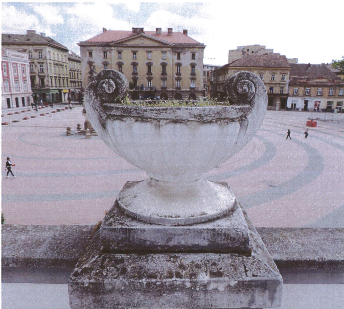
Lucrări de reabilitare a Pieței Libertății, care au inclus și schimbarea pavajului și punerea în valoare a spațialității pieței și revenirea la caracterul mineral tradițional al acesteia, în cadrul proiectului cofinanțat de Uniunea Europeană „Reabilitarea spațiilor publice din centrul istoric al Municipiului Timișoara” – imagine din mai 2015
