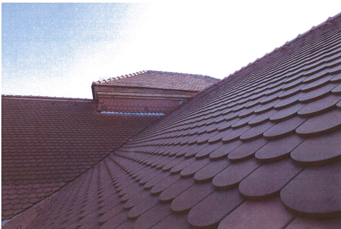
Lucrări realizate la acoperișul Colegiului Național „Constantin Diaconovici Loga” (Bd.C.D.Loga nr.37), în baza Programului de sprijin financiar KfW, „Reabilitarea monumentelor istorice din cartierele istorice ale Timișoarei” – Infrastructură municipală faza II (imagini 2015)
