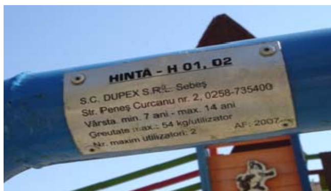
Modul corect de inscripționare al echipamentelor de joacă
