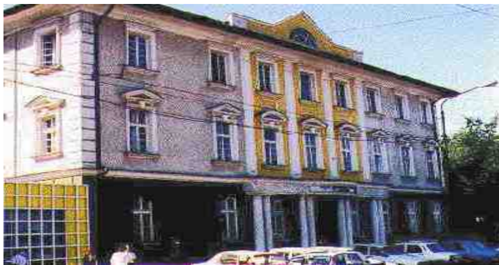
Sediu central: B-dul. Take Ionescu nr. 56, cod 300074, Timișoara, jud. Timiș. Vedere asupra sediului central.
